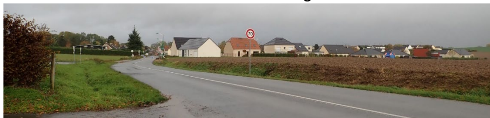
Mauvais état de conservation – mauvaise intégration
