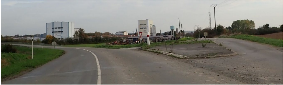
Exemple de covisibilité entre le clocher de l'église, l'hôtel de ville, la ligne électrique et les bâtis économiques
