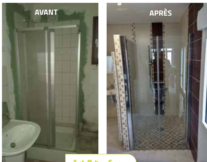
Installation d'une douche à l'italienne équipée pour personne à mobilité réduite
