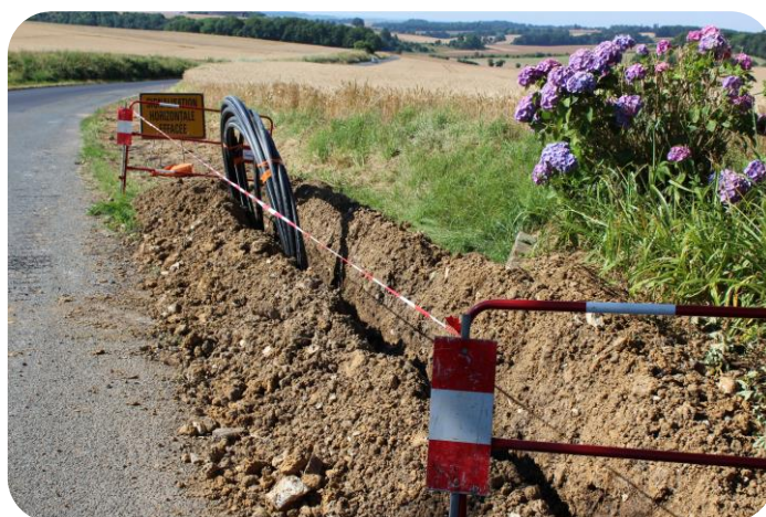
Travaux de raccordement fibre optique
