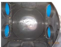
3. Le regard de bouclage vient boucler l'ensemble des drains. Étant au bout du système, il ne doit pas recevoir d'effluent. Il doit rester sec.
