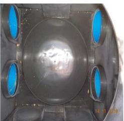
3. Le regard de bouclage vient boucler l'ensemble des drains. Étant au bout du système, il ne doit pas recevoir d'effluent. Il doit rester sec.
