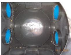
3. Le regard de bouclage vient boucler l'ensemble des drains. Étant au bout du système, il ne doit pas recevoir d'effluent. Il doit rester sec. *Note : il peut y avoir une faible présence d'eau due à la condensation et/ou de l'eau de pluie passant par un tampon ajouré.*
